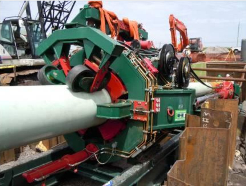
Der Herrenknecht Pipe Thruster drückt in Arcadia, USA, mit durchschnittlich 15 Tonnen Schubkraft die Direct Pipe ® Maschine und die Pipeline vorwärts.
