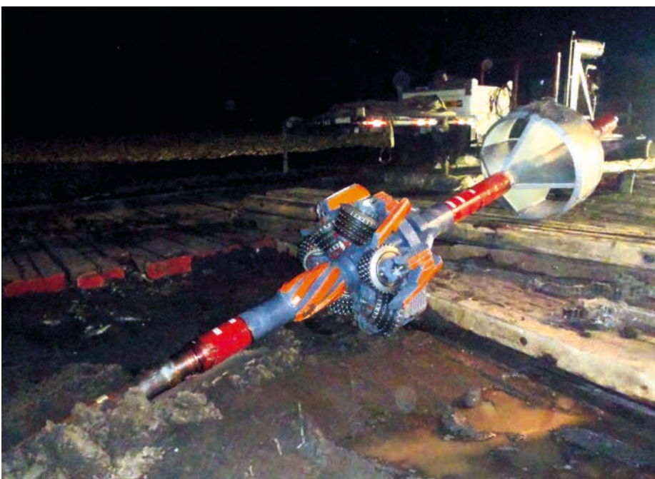
Neuer Full Face Hole Opener im Bohrloch
