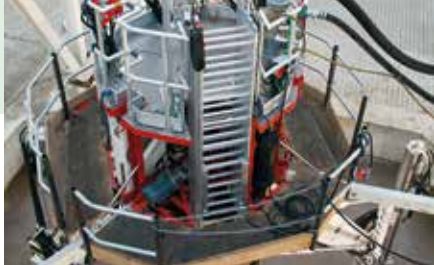
带有爬梯的操作平台
