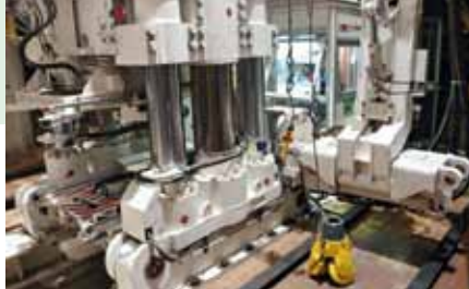
2010年11月12日：反井钻机RBR550VF进行导向钻进组装。
