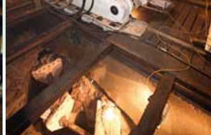
2011年1月18日：在钻进了280米的深度后，扩孔器到达最终目的地。
