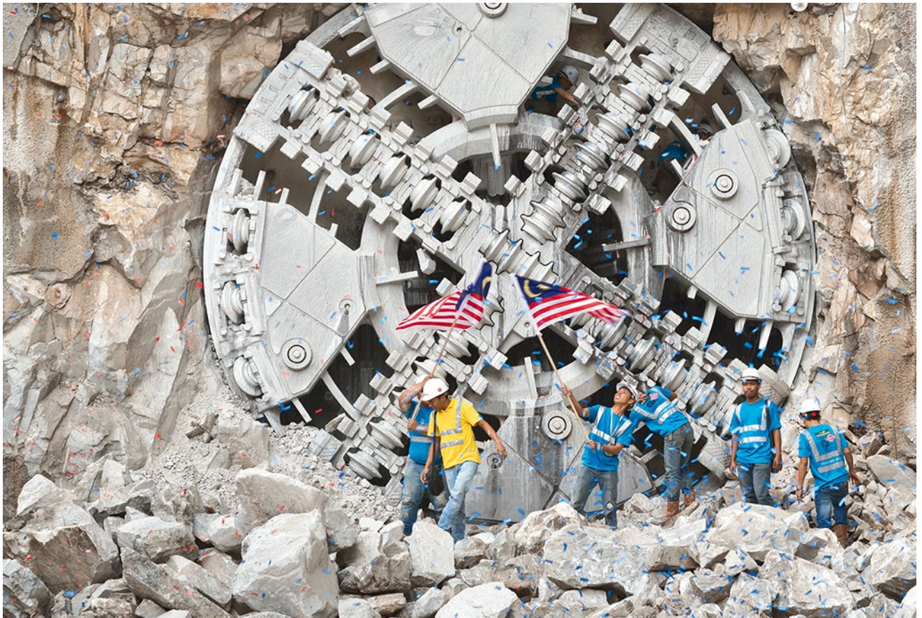
09.01.2014: Der weltweit erste Durchbruch mit einer Variable-Density-TBM in der Hauptstadt von Malaysia.
