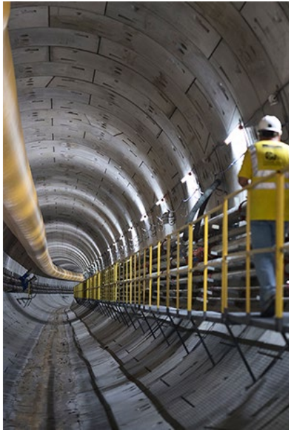
Teilabschnitte der einspurigen Tunnel mit einem Durchmesser von jeweils 6,62 m sind bereits fertiggestellt.
